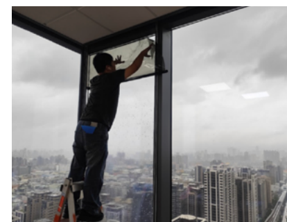
安裝玻璃隔熱膜
